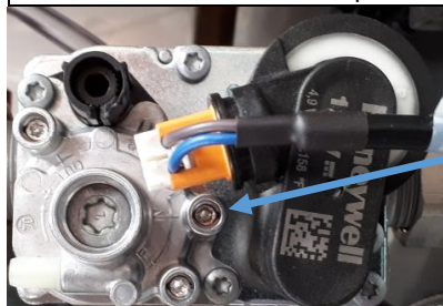
**Raccord de pression de la vanne de gaz
